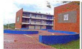
Construcción de nuevos edificios del Centro de Biociencias-Tapachula.
