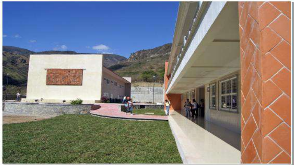
Nuevos edificios en el Centro Mezcalapa de Estudios Agropecuarios-Copainalá.
